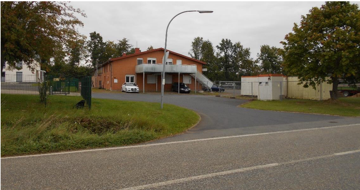
Abbildung 3: Angrenzender Gewerbebetrieb mit Erschließungsstraße (eigene Aufnahme September 2017)
