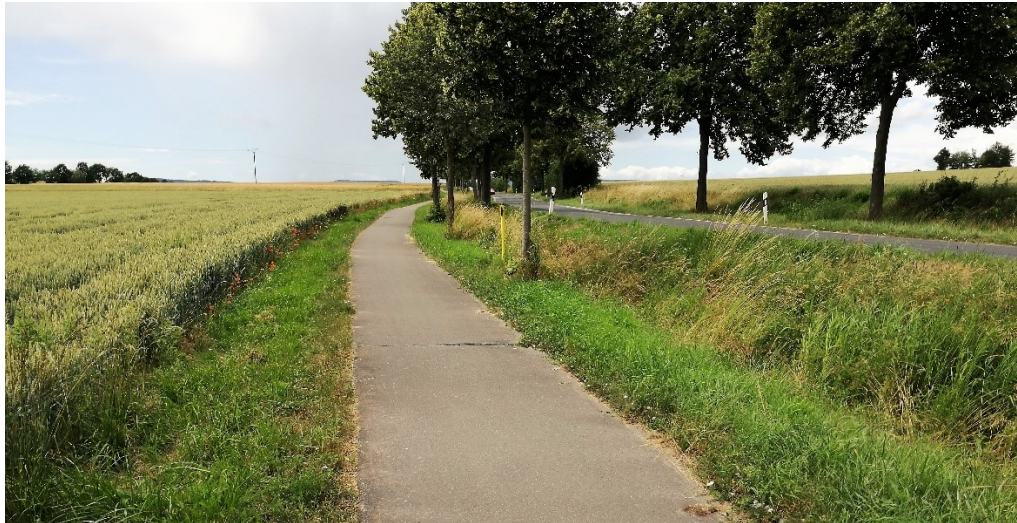
Blick vom Radweg nach Westen (nach Germershausen)
